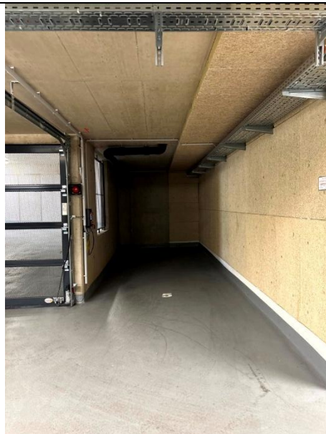
Abbildung 156: Tiefgarage – Stellplatz AP 5 (M7)
