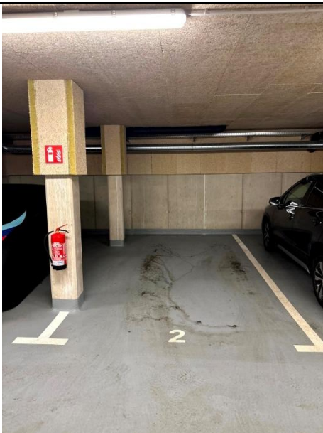
Abbildung 155: Tiefgarage – Stellplatz AP 2 (M7)
