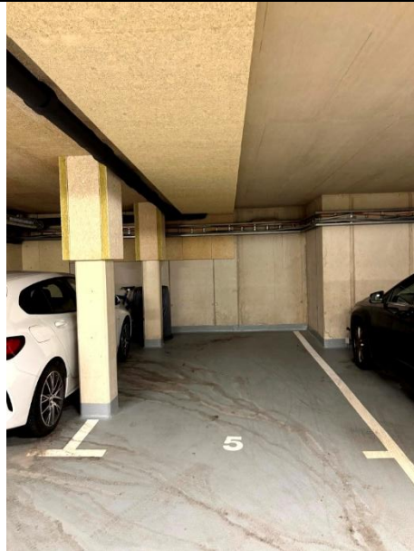
Abbildung 154: Tiefgarage – Stellplatz AP 5 (M9)
