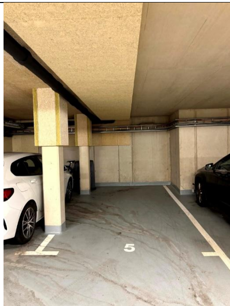
Abbildung 151: Tiefgarage – Stellplatz AP 5 (M9)
