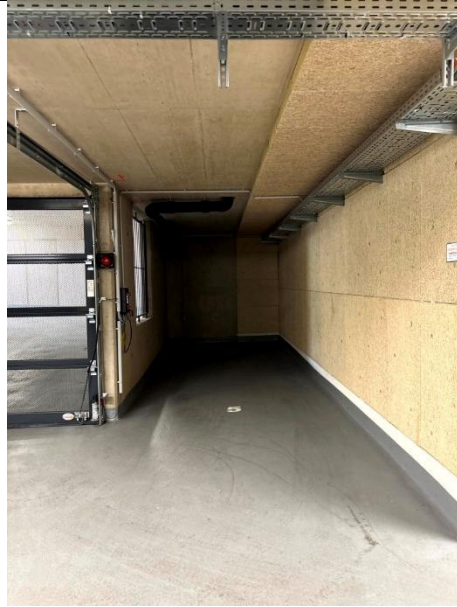
Abbildung 153: Tiefgarage – Stellplatz AP 5 (M7)
