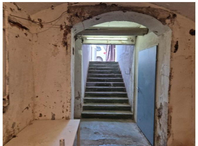
Abbildung: Zugang zum Keller
