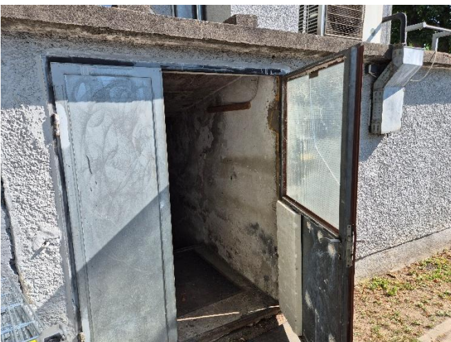
Abbildung: Zugang zum Keller
