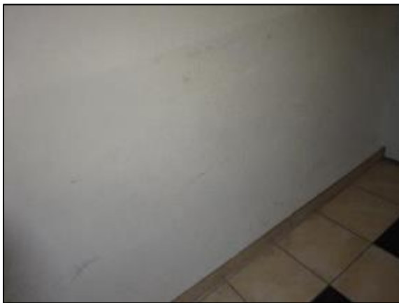
Abbildung 45: Feuchtigkeitsschäden im Stiegenhaus
