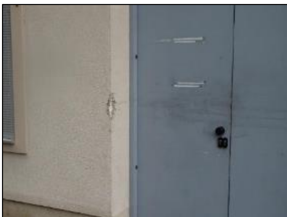
Abbildung 43: Fassadenschäden im Zutrittsbereich des Müllraums (Teil 1)
