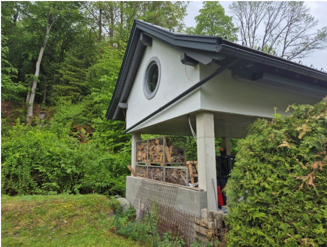
Abbildung: Eventueller Grenzüberbau
