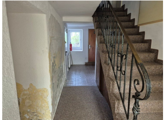
Abbildung: Gangbereich, Treppe in das Obergeschoß
