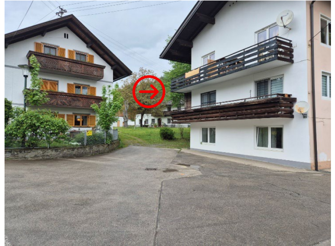
Abbildung: Blick auf die Liegenschaft EZ 1064 (Pfeil)
