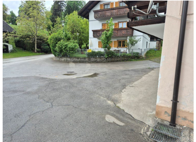
Abbildung: Blick auf die Zufahrt zur Liegenschaft sowie auf die Nachbarliegenschaft
