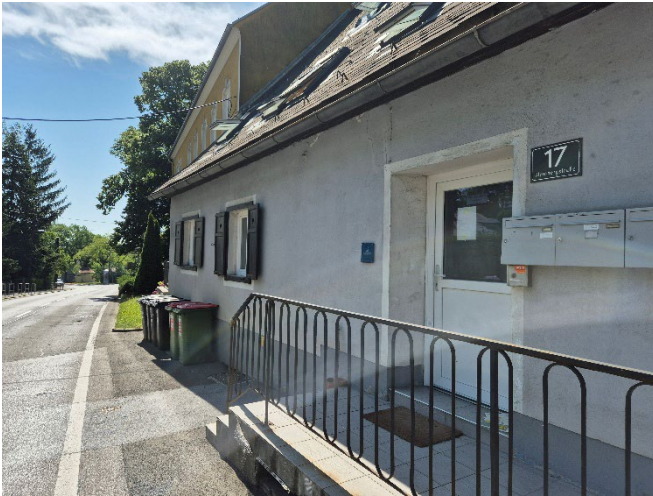
Abbildung: Zugang zur Liegenschaft
