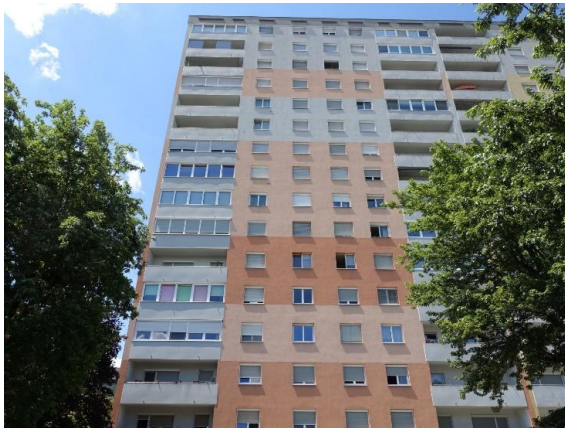
Abbildung: Blick auf die Ostfassade
