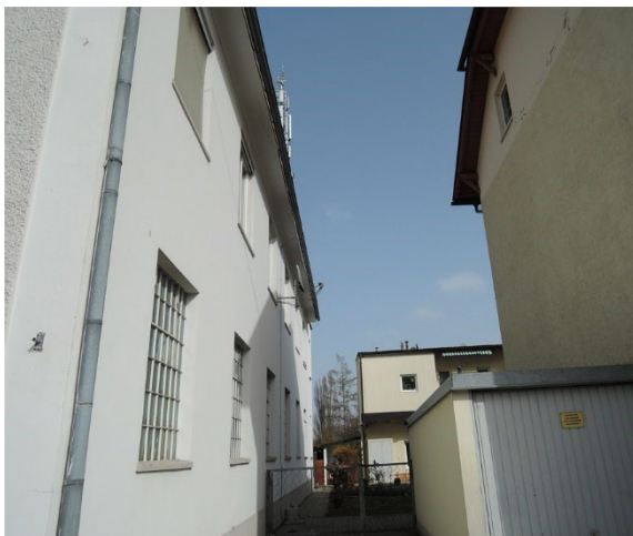
Abbildung: Zugang zum Innenhof und zu ON 37a; vorne: ehemalige Garage (dzt. Lager / Müllraum)
