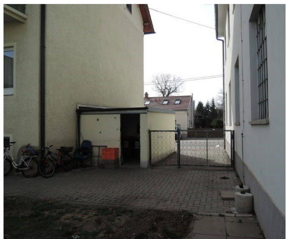
Abbildung: Zugang zur Liegenschaft, Müllraum (ehemalige Garage)
