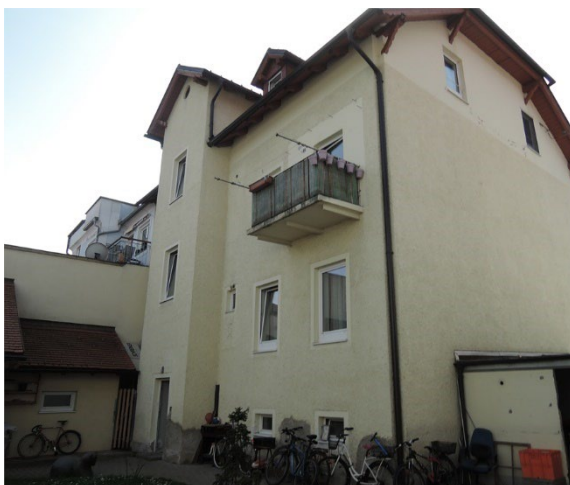
Abbildung: Objekt mit der ON 37, Hoffassade und Zugang
