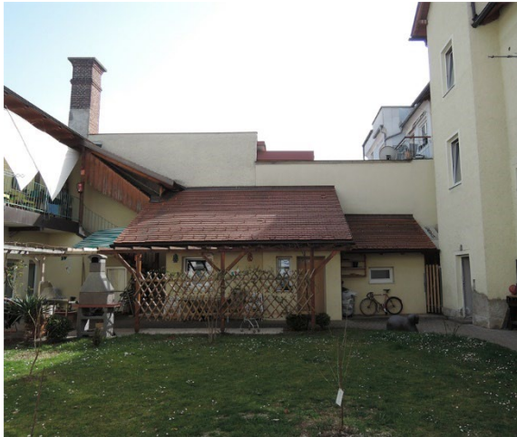
Abbildung: Objekt mit der ON 37a im Innenhof (Nebengebäude)
