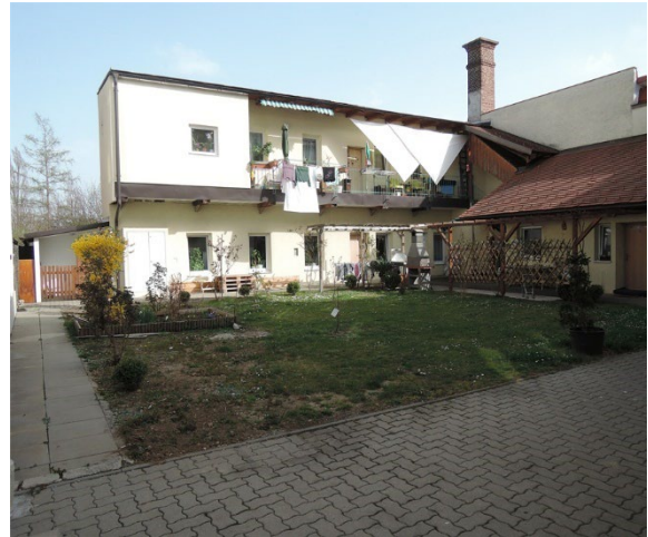
Abbildung: Objekt mit der ON 37a im Innenhof (Nebengebäude)
