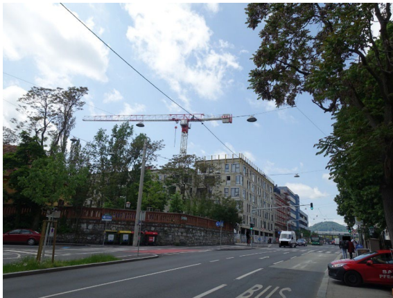
Abbildung: Blick in die Keplerstraße, Richtung Westen zum Hauptbahnhof
