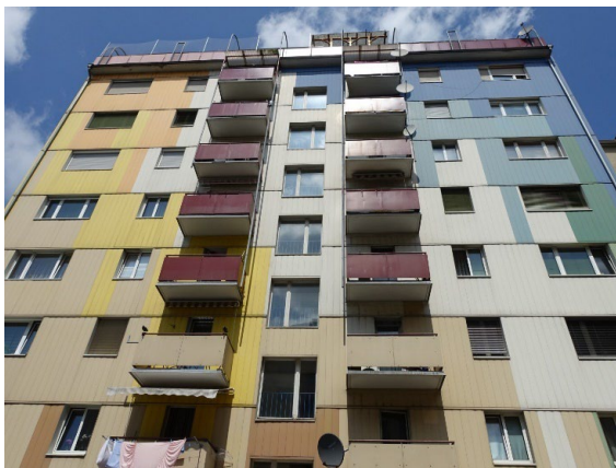
Abbildung: Fassade Innenhof
