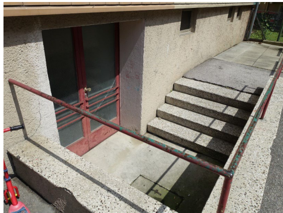
Abbildung: Zugang zum Keller im Innenhof
