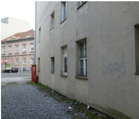
Abbildung: Hofseitige Fassade
