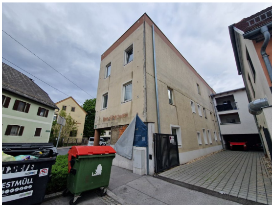
Abbildung: Blick auf das Bestandsobjekt
