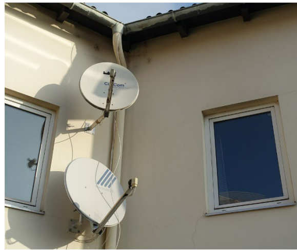
Abbildung: Hofseitige Fassade
