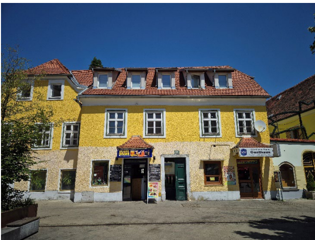
Abbildung: Blick auf die Liegenschaft (Südansicht)
