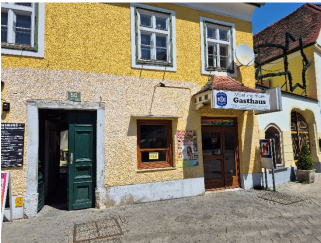
Abbildung: Blick auf die Liegenschaft (Südansicht)
