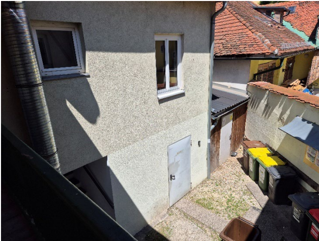
Abbildung: Blick auf den Müllplatz (Innenhof)
