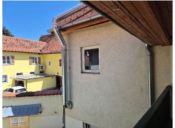
Abbildung: Blick auf die Hoffassade
