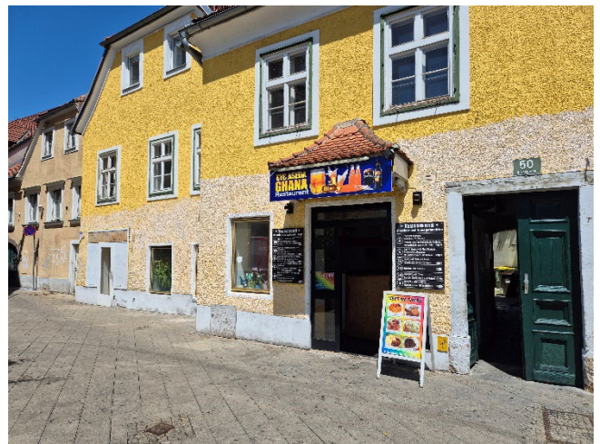
Abbildung: Blick auf die Liegenschaft (Südansicht)
