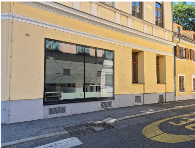
Abbildung: Ansicht Liegenschaft / Büro im EG
