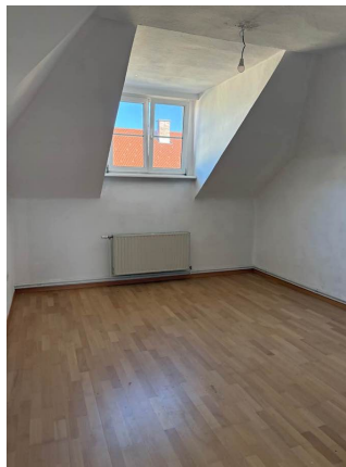
Der Fensterstock der Gaube liegt bei 1,70m
