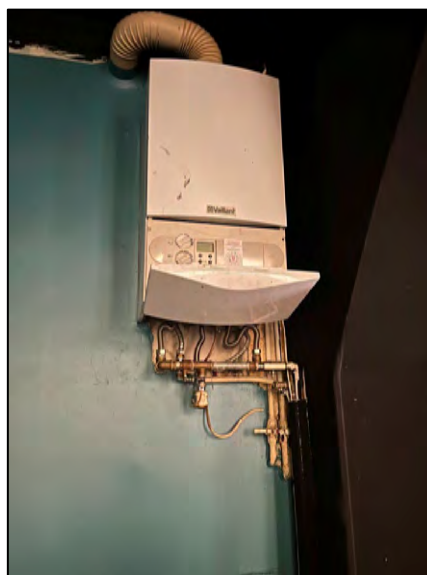
Warmwasseraufbereitung/Therme
