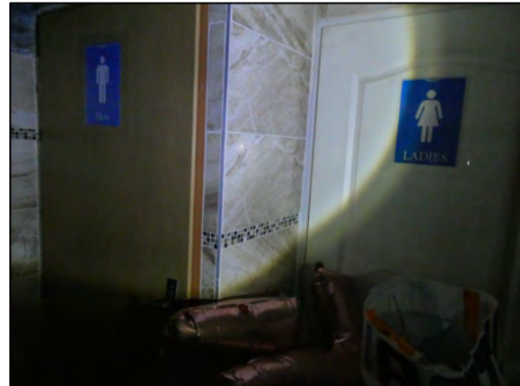
nachträglicher WC-Einbau, KG
