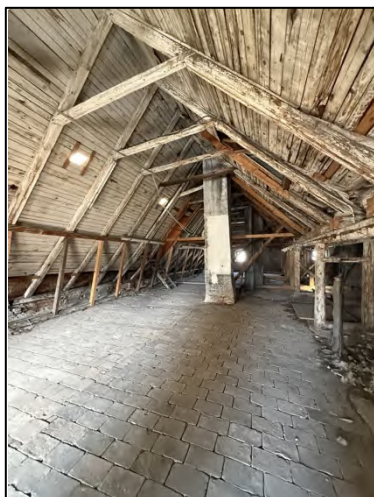
Dachboden Haus Nr. 7
