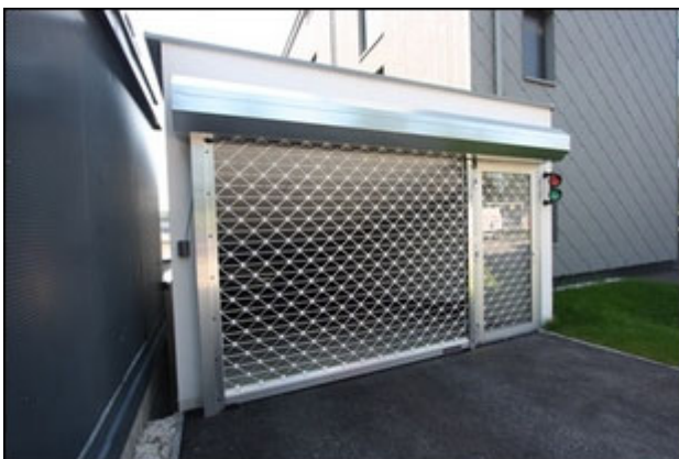
Abb.5 Ansicht TG-Einfahrt, Toranlage
