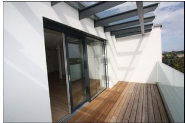
Abb.36 Ansicht Wohnung Top 12, DG 2, Loggia
