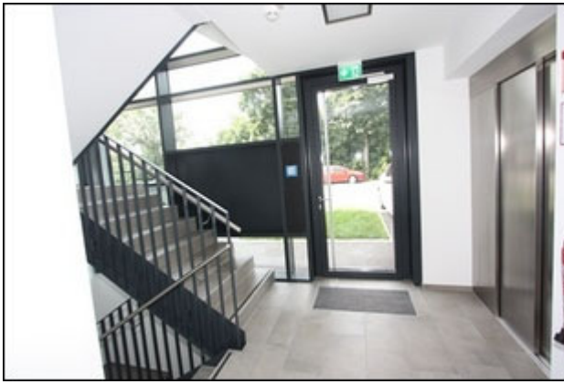
Abb.7 Ansicht Stiegenhaus EG, rechts: Liftanlage
