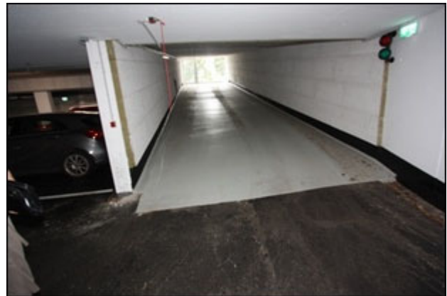
Abb.12 Ansicht Tiefgarage, Rampe
