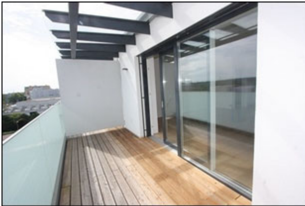
Abb.35 Ansicht Wohnung Top 12, DG 2, Loggia
