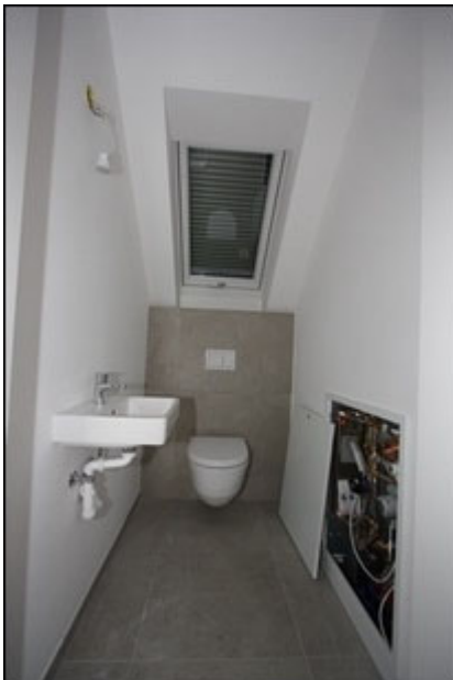
Abb.17 Ansicht Wohnung Top 12, DG 1, WC
