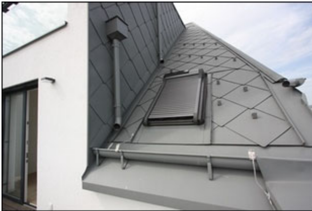
Abb.29 Ansicht Wohnung Top 12, DG 1, Terrasse Dachabschnitt Gebäude Südost
