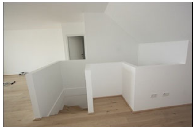
Abb.32 Ansicht Wohnung Top 12, Stiegenausgang DG 2
