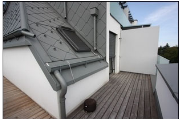
Abb.20 Ansicht Wohnung Top 10, DG 1, Terrasse Süd/West
