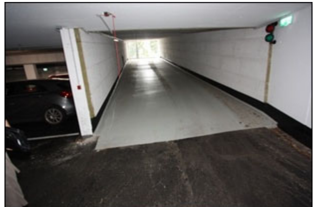
Abb.12 Ansicht Tiefgarage, Rampe
