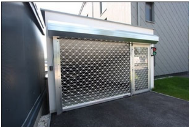
Abb.5 Ansicht TG-Einfahrt, Toranlage
