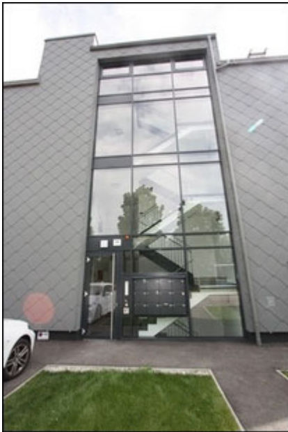
Abb.3 Ansicht Detail zu Abb.1/2, Hauseingang, Stiegenhaus
