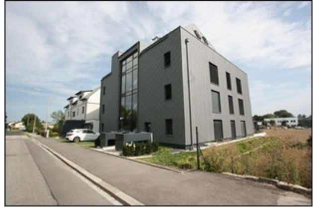
Abb.2 Ansicht Liegenschaft, Wohngebäude Neubauzeile 49 Südwest-/Straßenseite
