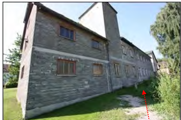
Abb.6 Ansicht Nachbargebäude Hauptstr. 27, öffentl. Gehweg (vgl. Abb.5)
