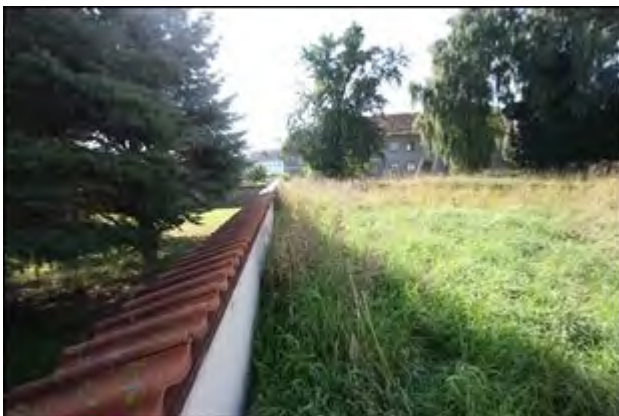
Abb.11 Ansicht Bauparzelle (Gst. 1), Richtung Süden links: Einfriedungsmauer östliches Nachbargrundstück
