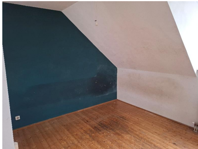
Dachschrägen & Feuchtigkeitsschäden
