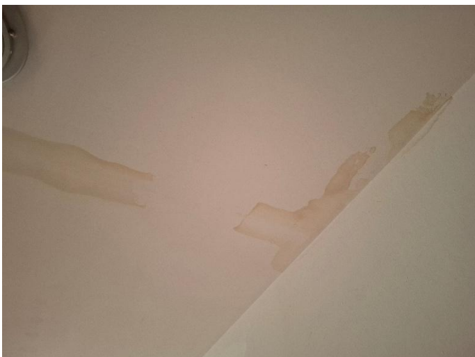
Feuchtigkeitsschäden
