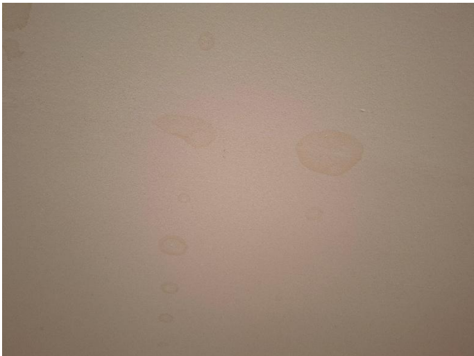
Feuchtigkeitsschäden
