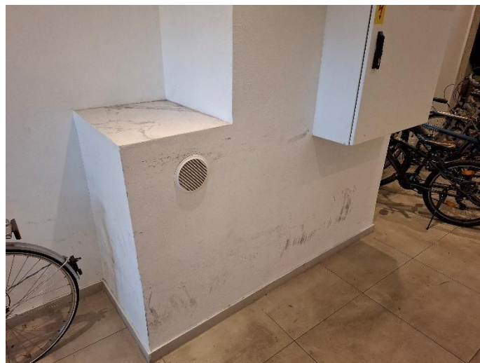
Abnutzungen durch unsachgemäßen Gebrauch
