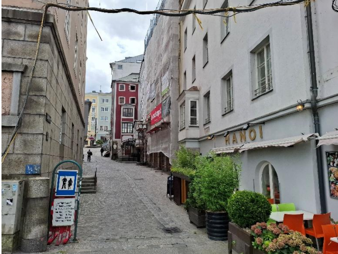
Ausschnitt Straßenfassade, Hofberg
