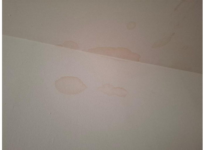
Feuchtigkeitsschäden
