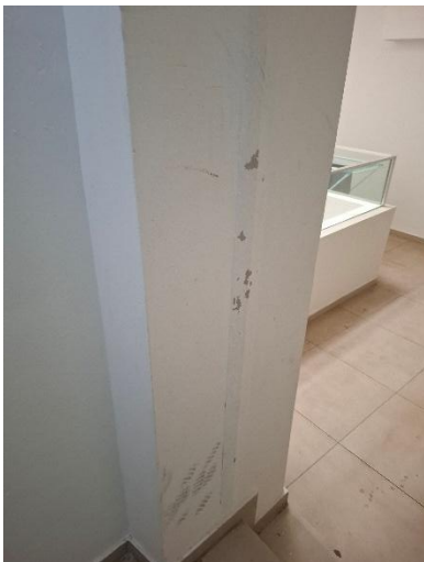
Abnutzungen/ Beschädigungen
