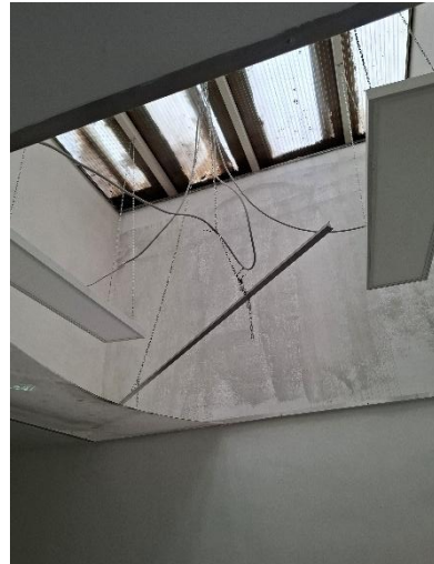
Verschmutzungen, Feuchtigkeit
