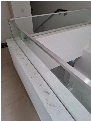
Verschmutzungen, Feuchtigkeit
