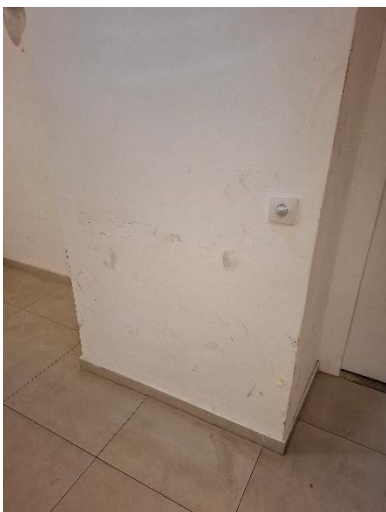
Abnutzungen durch unsachgemäßen Gebrauch
