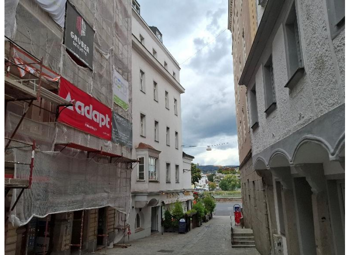
Ausschnitt Straßenfassade, Hofberg
