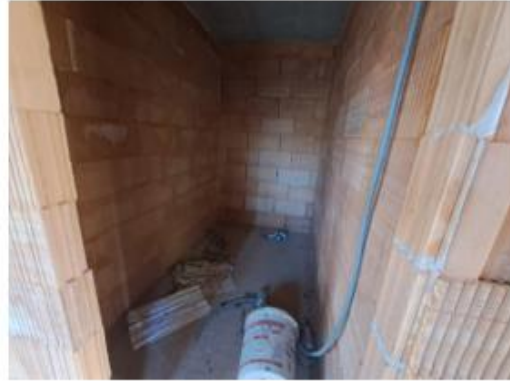
Zimmer mit Terrasse Nordseite
