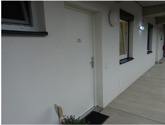
Abbildung: Zugang W 12
