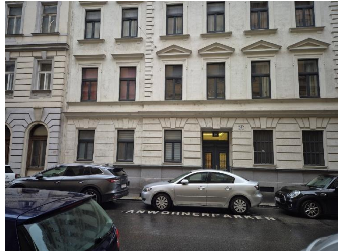
Abbildung: Ansicht Liegenschaft / Zugang zur Liegenschaft
