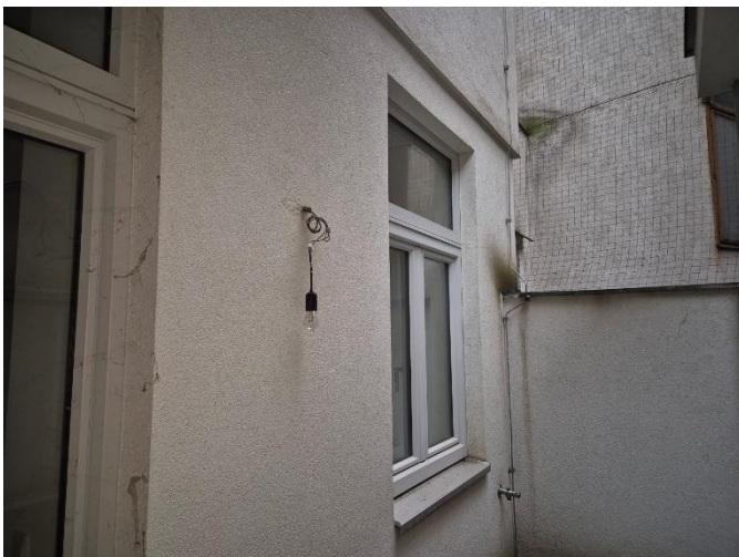
Abbildung: Fassade hofseitig
