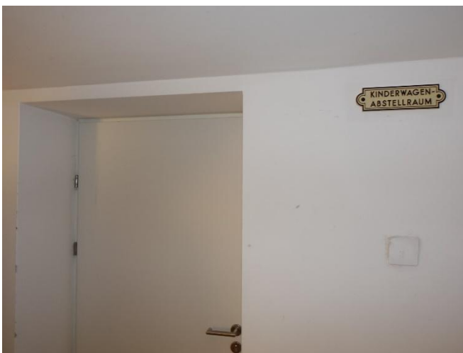
Abbildung: Zugang Kinderwagenabstellraum (Befundaufnahme 2024)
