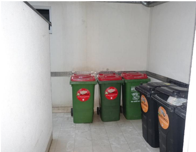
Abbildung: Müllbereich (Befundaufnahme 2024)
