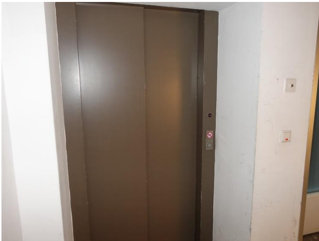
Abbildung: Lift (Befundaufnahme 2024)
