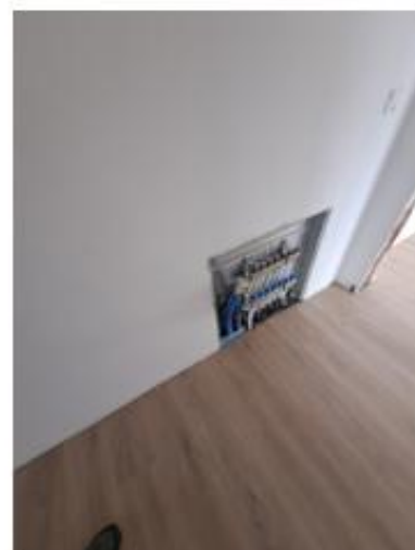
Fußbodenheizung Verteiler
