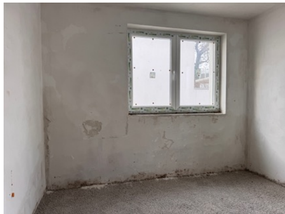
Feuchteschäden Wand
