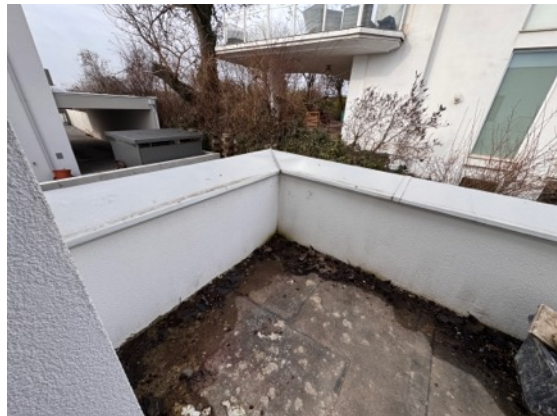
Balkon bzw. Terrasse
