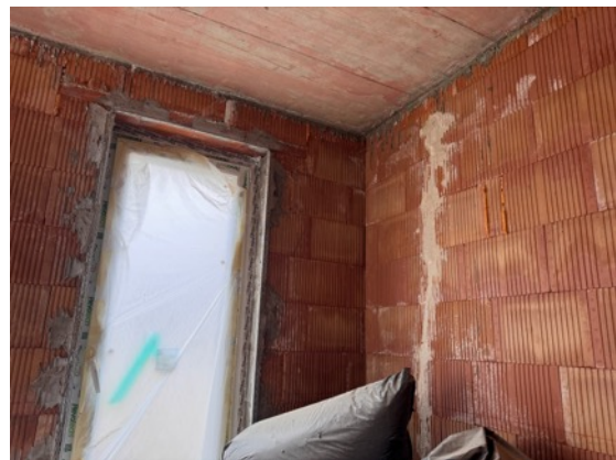
Durchfeuchtete Außenwände
