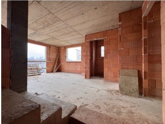
Wohnen/Essen – Blickrichtung Stiegen zu AR/Küche
