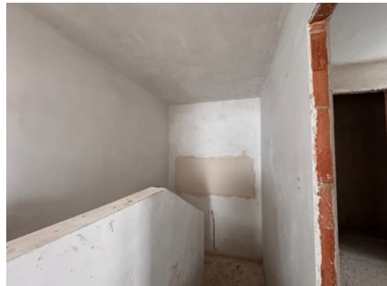
Stiegenhaus (Fenster zugemauert)
