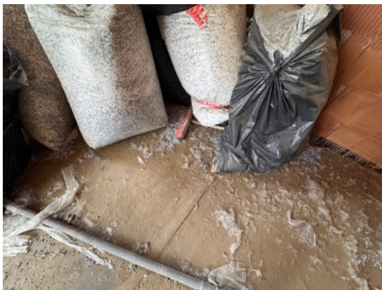
Feuchtigkeitsschäden Boden
