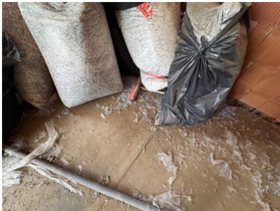
Feuchtigkeitsschäden Boden
