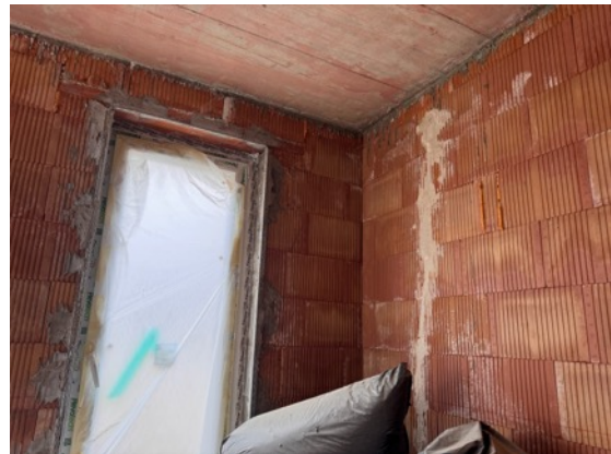
Durchfeuchtete Außenwände
