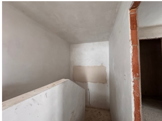
Stiegenhaus (Fenster zugemauert)
