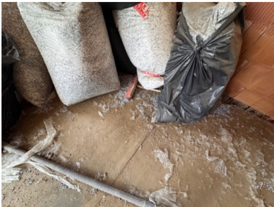
Feuchtigkeitsschäden Boden
