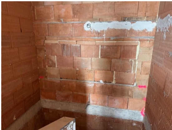
Stiegenaufgang (Fenster zugemauert)
