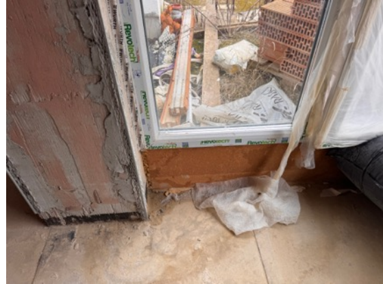
Durchfeuchtete Türkonstruktion
