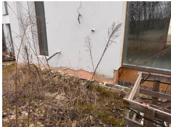
Fassadenschäden Sockelbereich
