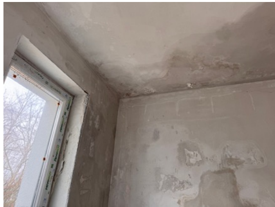
Durchfeuchtete Außenwände
