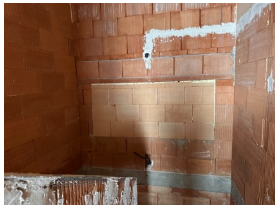
Stiegenhaus (Fenster zugemauert)
