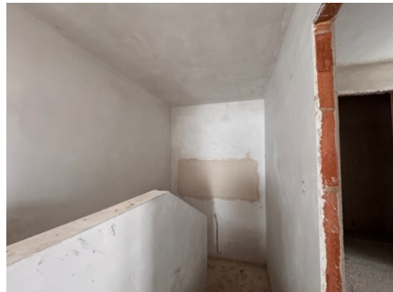
Stiegenhaus (Fenster zugemauert)
