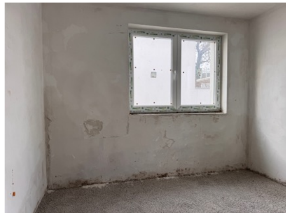
Feuchteschäden Wand
