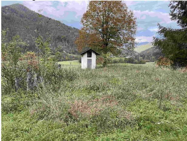
Brunnengebäude auf Grundstück 95/6
