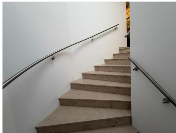
Foto 26: DG Wohnung | Aufgang 2.DG
