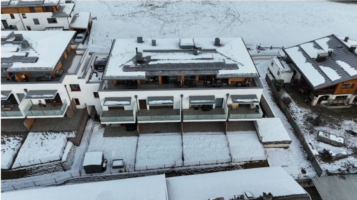
Südansicht Bauteil C
