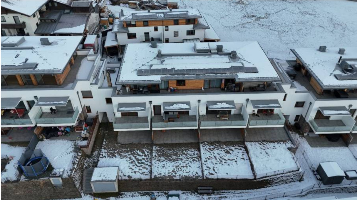
Südansicht Bauteil B
