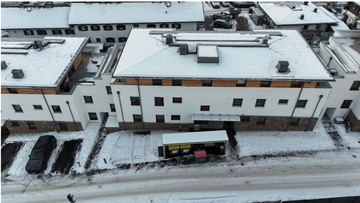
Nordansicht Bauteil B
