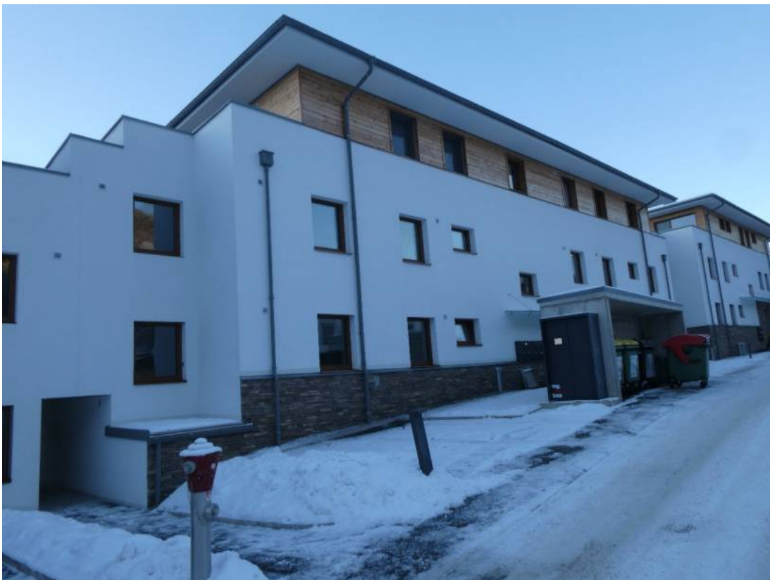
Nordostansicht Bauteil B
