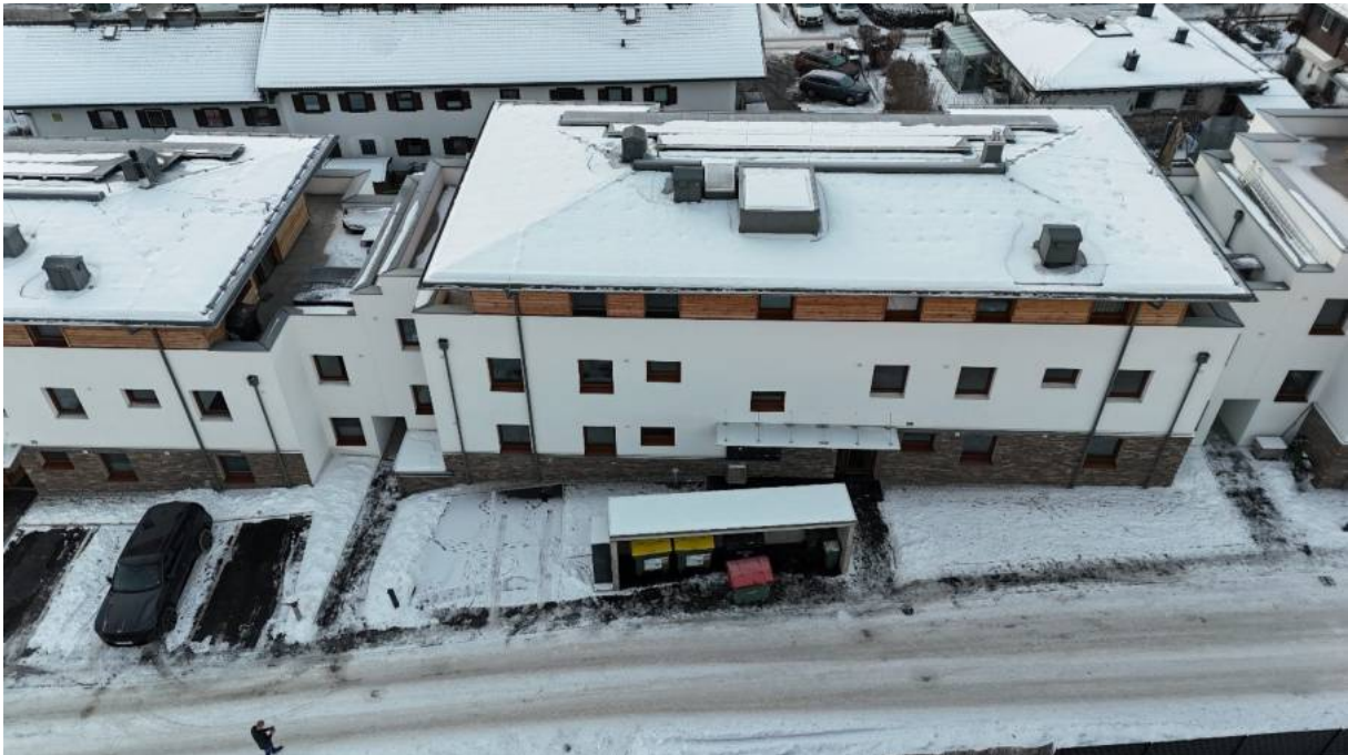
Nordansicht Bauteil B
