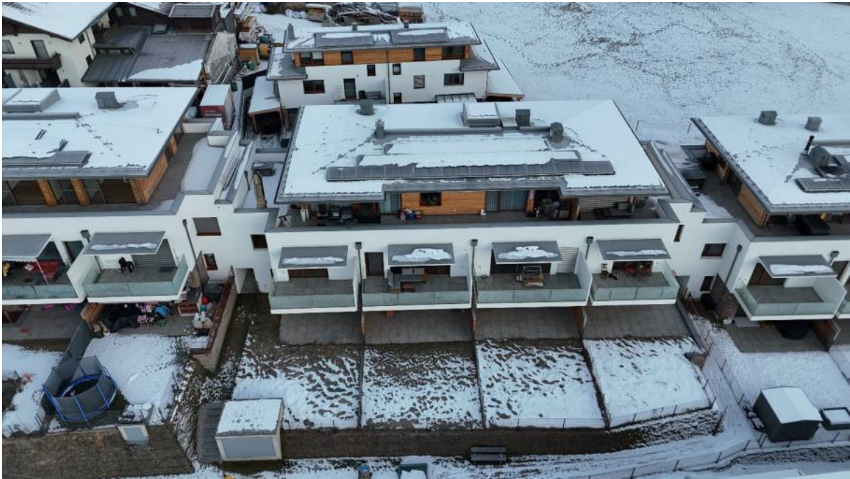
Südansicht Bauteil B
