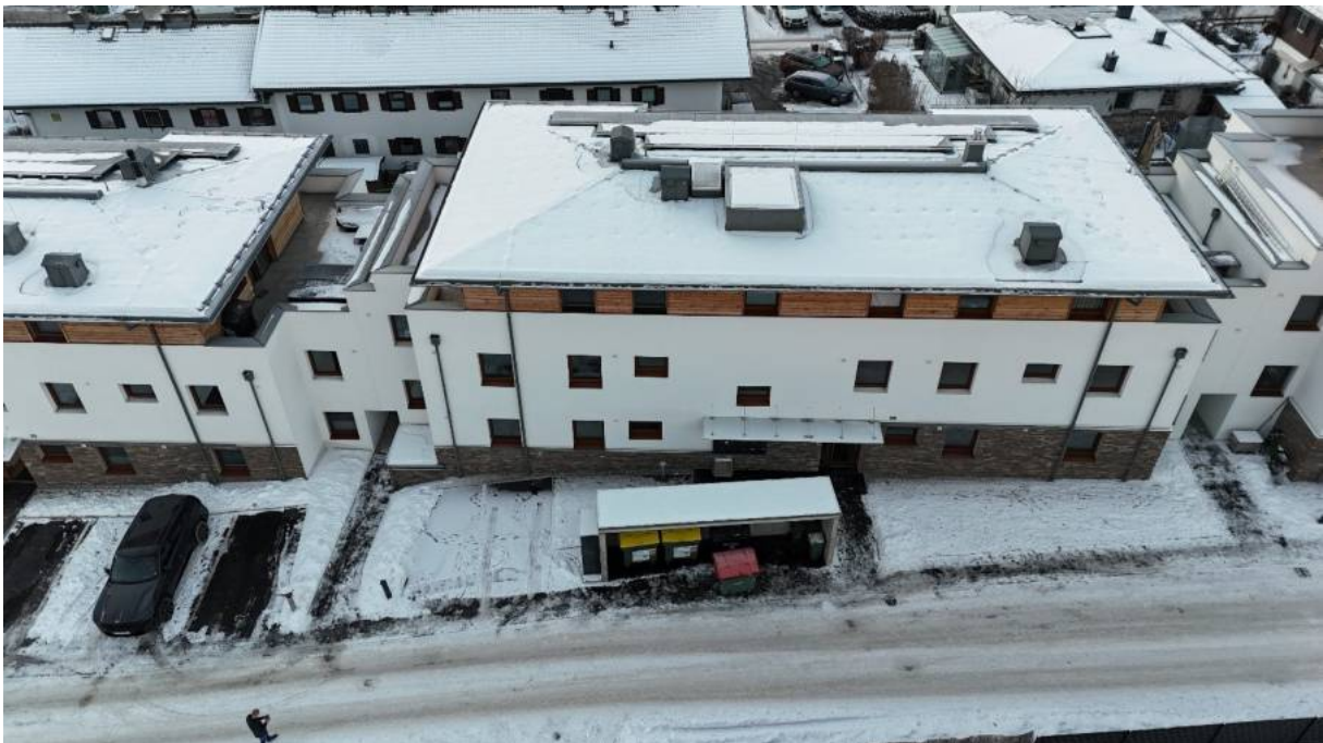
Nordansicht Bauteil B
