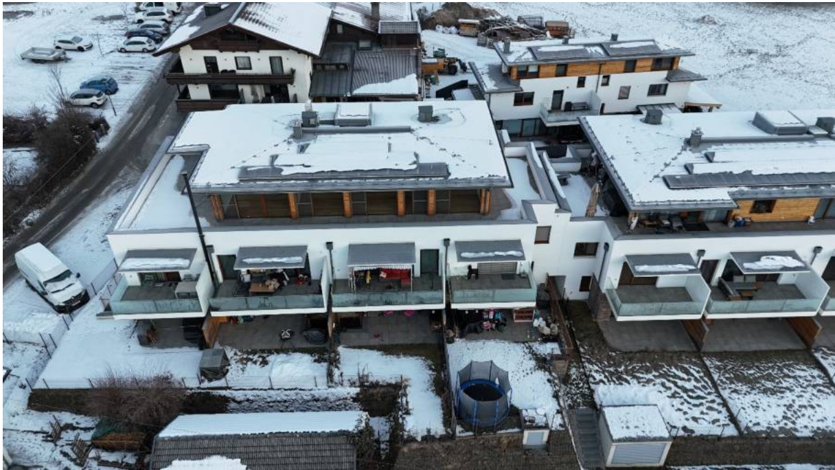
Bauteil A Südansicht
