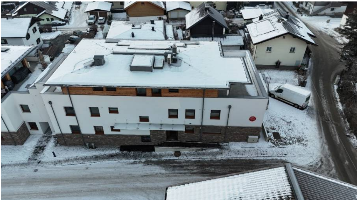
Bauteil A Nordansicht
